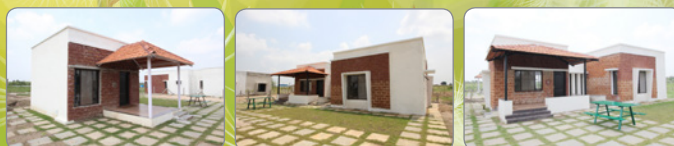
Actual site photographs
